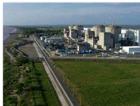
Centrale de Blaye
